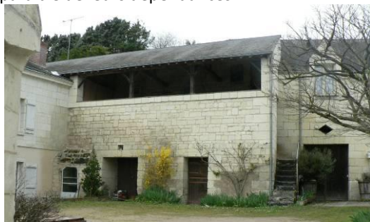
Bâtiment agricole dans le bourg
